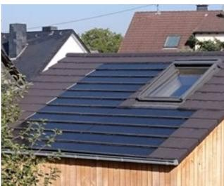
**b** Die Indachlösung der Solaranlage ist auf das Dachflächenfenster abgestimmt.
