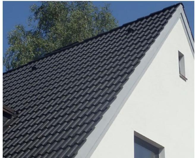
**a** Typische kleinformatige Dacheindeckung mit profilierten Dachziegeln und matter Farbgebung
