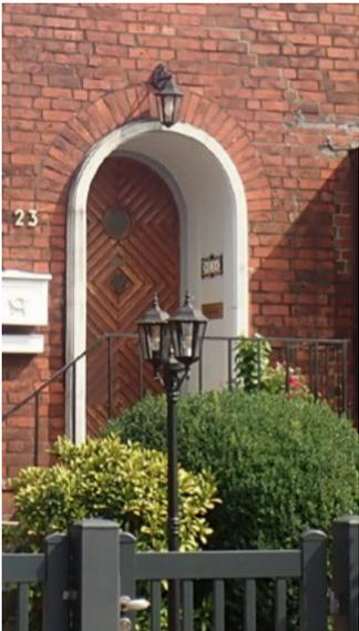
**b** Türeinpassung aus weißem bossiertem Naturstein und Klinkersturz als gemauerte Rollschicht
