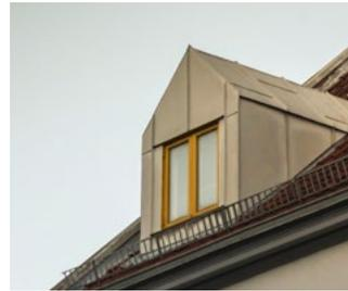
**g** Moderne Gauben: Kleine Sattelgaube mit Stehfalz-Verkleidung (oberes Bild) und breite Kastengaube mit Holzverkleidung (unteres Bild)
